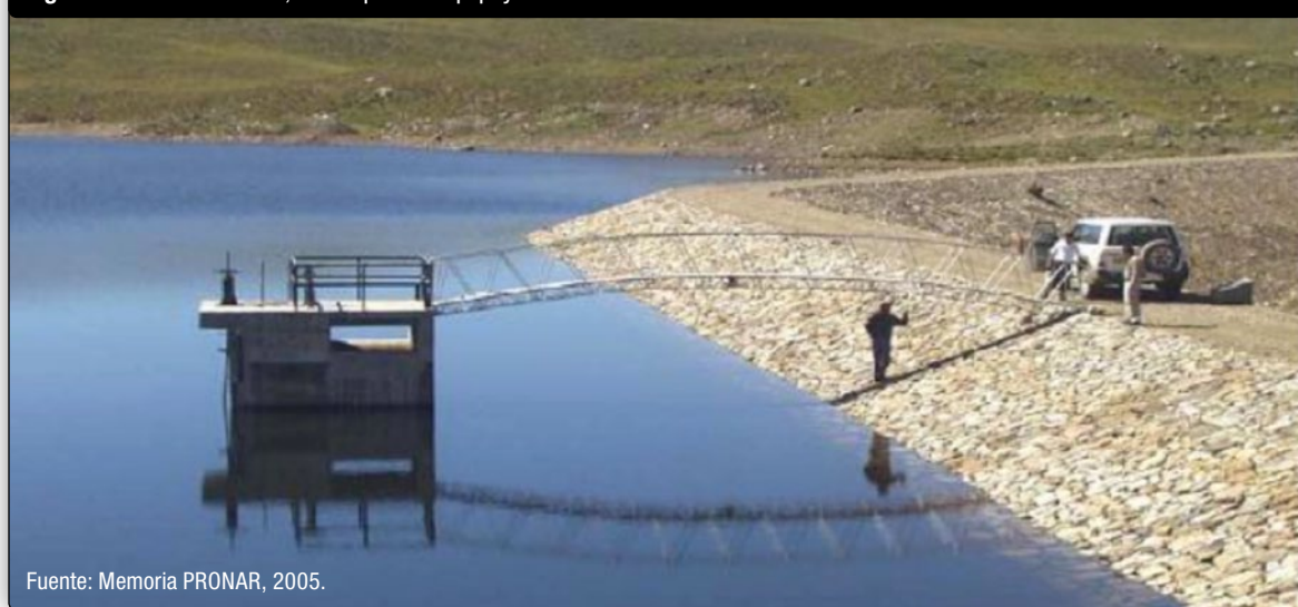
Figura 13. Presa de tierra, Municipio de Tiquipaya-Cochabamba
