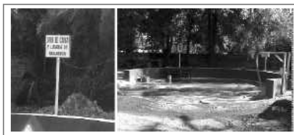
Figura 41. Pozo de almacenamiento de agua residual
